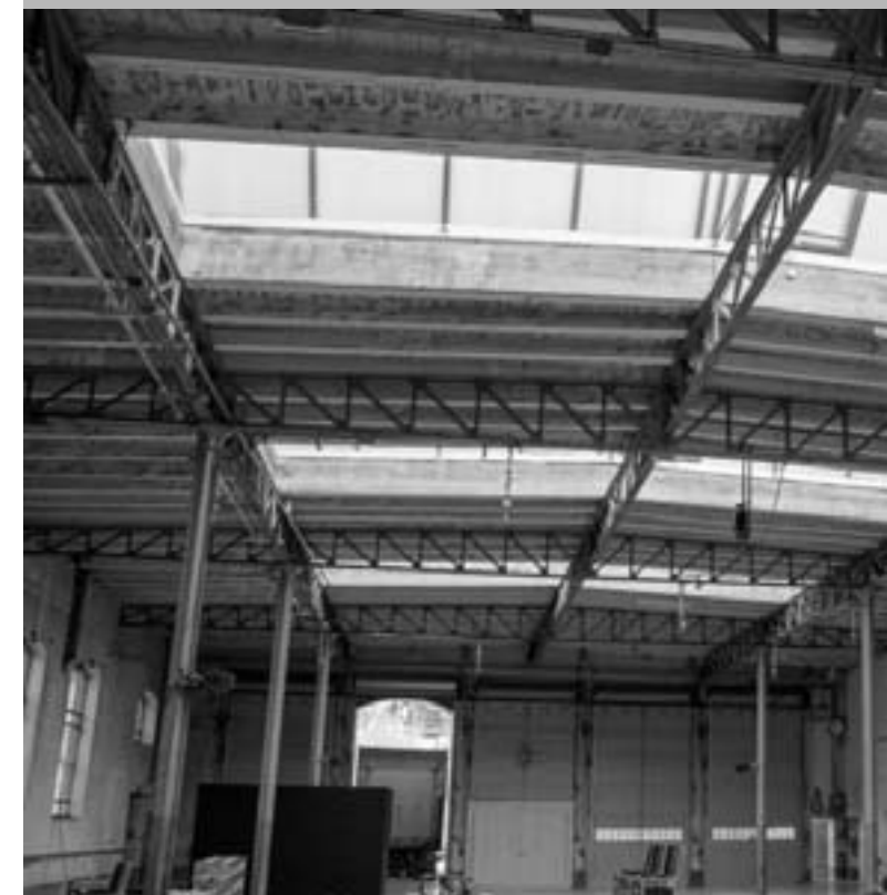
Soll vor dem Abbruch nochmals belebt werden: Die grosse Halle des Tramdepots Burgernziel.
